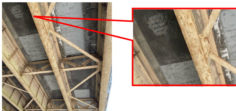
床版の損傷状況イメージ ※床版を下から撮影
