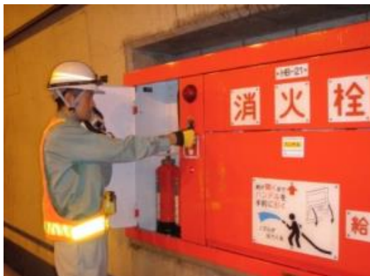
トンネル非常用設備点検
