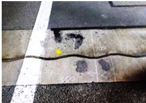
橋梁補修(橋梁の伸縮装置)
