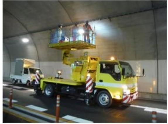
<トンネル照明設備点検状況>
