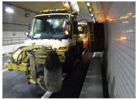
<トンネル壁面清掃状況>
