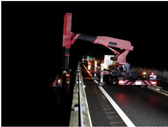
<橋梁点検状況>
