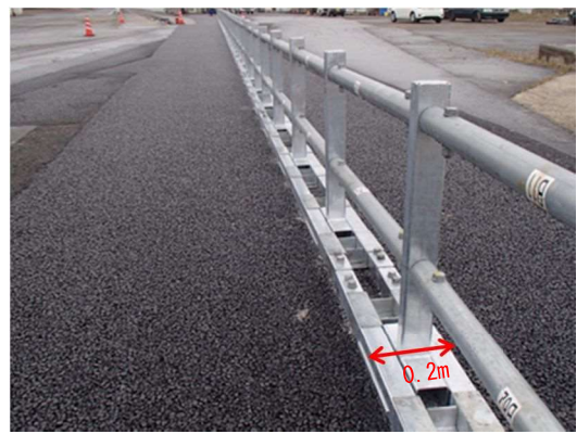
新たな区画柵の試行〔センターパイプ〕
