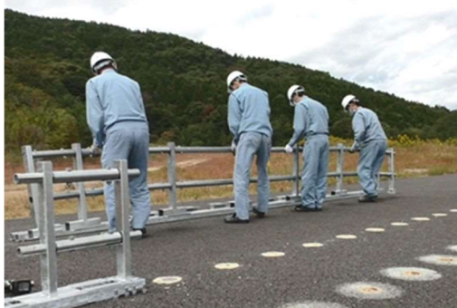
センターパイプ(部材取外し後)
