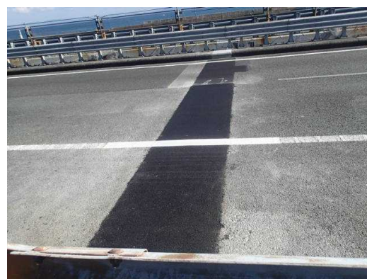
写真④ 工事完成(イメージ)
