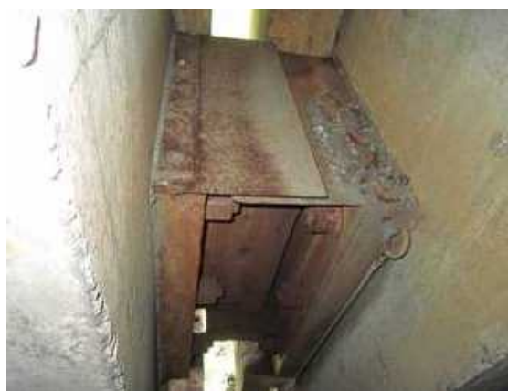
写真② 連結装置の拡大写真(現況)
