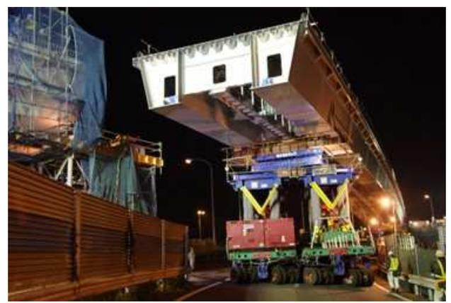
(多軸台車で橋桁を運搬する事例)
