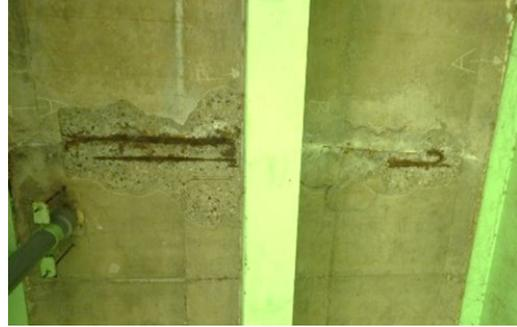
いずれもコンクリート床版を下から見上げた状況の写真です。表面のコンクリートが剥がれ、内部の鉄筋が見えている状況となっています。（表面のコンクリートの剥がれは、定期点検時に剥がれて落下する危険性がある範囲をあらかじめ叩き落としたものです。）
