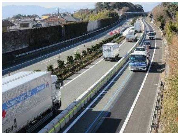
【コンクリート防護柵設置状況の例】
