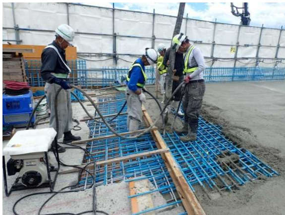
【現場打ち床版の施工状況】
