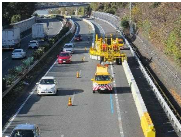
【コンクリート防護柵設置状況の例】
