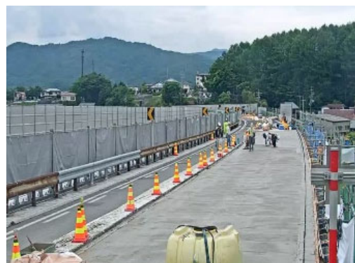
コンクリート床版の打設工事(走行車線施工時の工事の様子 2021年6月撮影)
