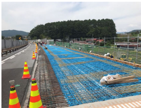
コンクリート床版の打設工事(走行車線施工時の工事の様子 2021年6月撮影)
