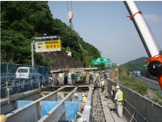
老朽化した床版を撤去
