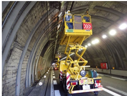
トンネル照明の点検
