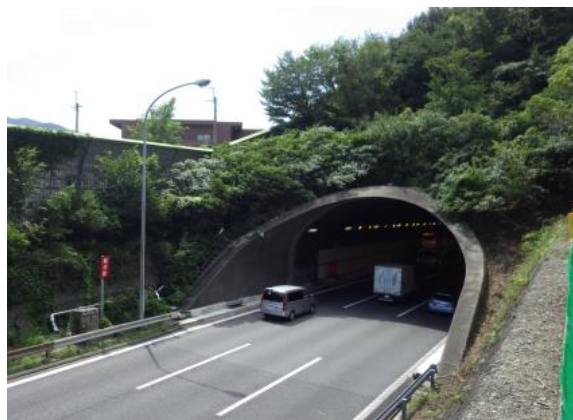
樹木繁茂状況
