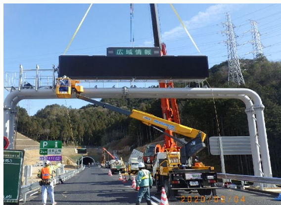
取替工事イメージ
