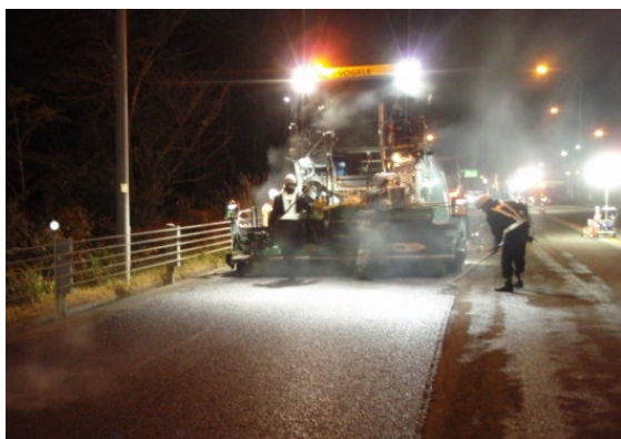
舗装工事(イメージ)
