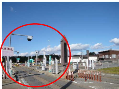
ETC 設備更新工事
