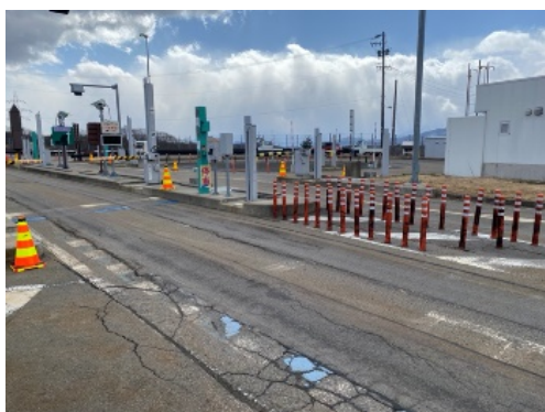
舗装補修工事
