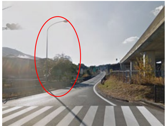
道路照明設備の撤去 ※代替照明を整備します
