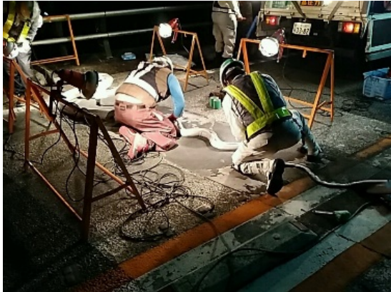
橋梁伸縮装置補修
