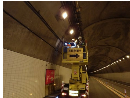
トンネル照明設備点検
