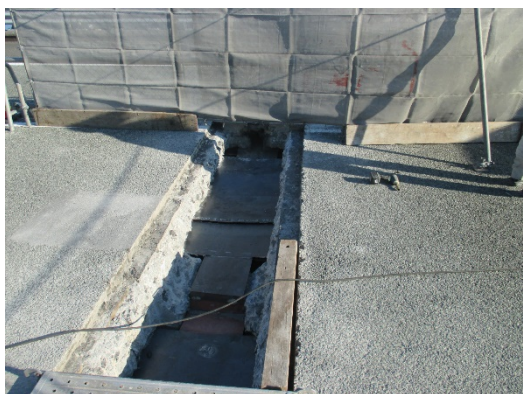
写真③ 工事中(イメージ)
