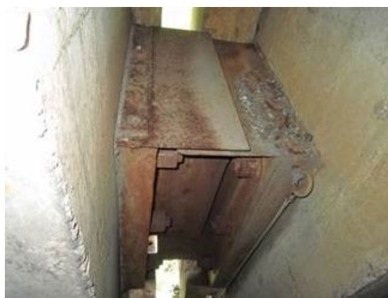
写真② 連結装置の拡大写真(現況)
