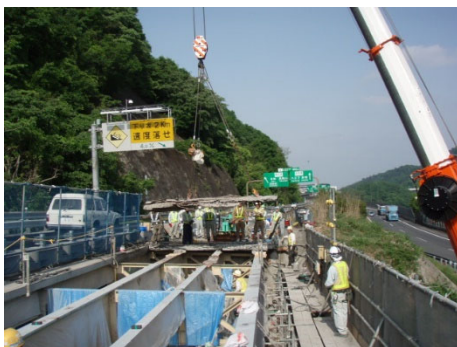
老朽化した床版の撤去
