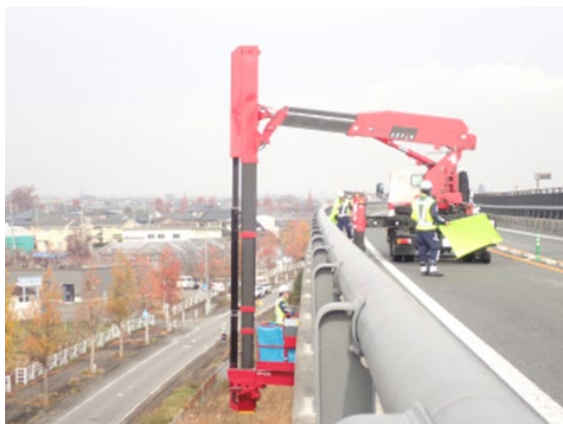
<橋梁点検状況>
