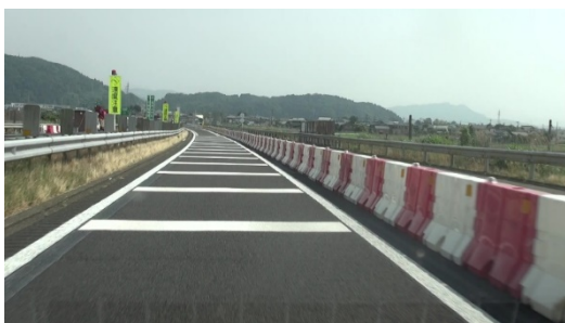
(対面通行シフト部の薄層舗装設置例)
