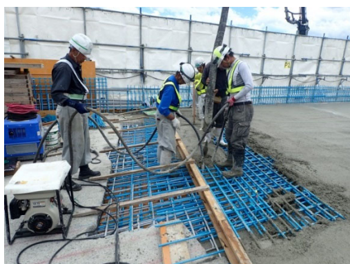
現場打ち床版の施工
