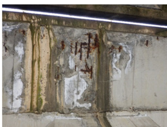
中津川橋の損傷状況 ※床版を下から撮影
