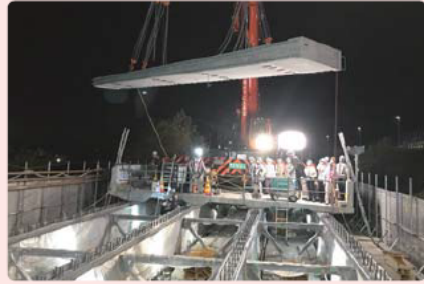
新しい床版の設置の様子
