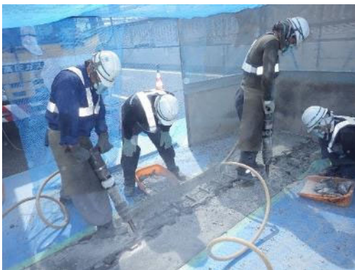
施工中イメージ
