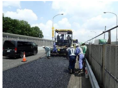
舗装工事イメージ
