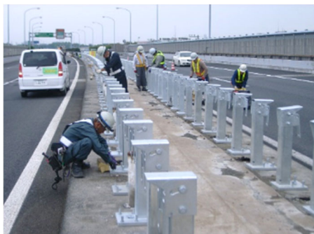
施工中イメージ
