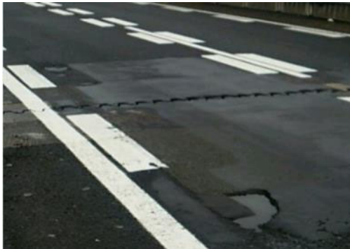
舗装の損傷状態イメージ
