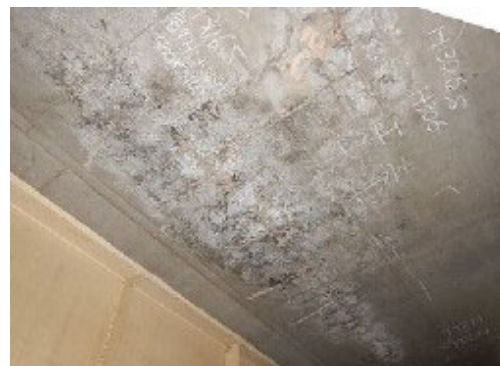
コンクリート床版の損傷状況(イメージ)
