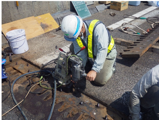
伸縮装置補修工事
