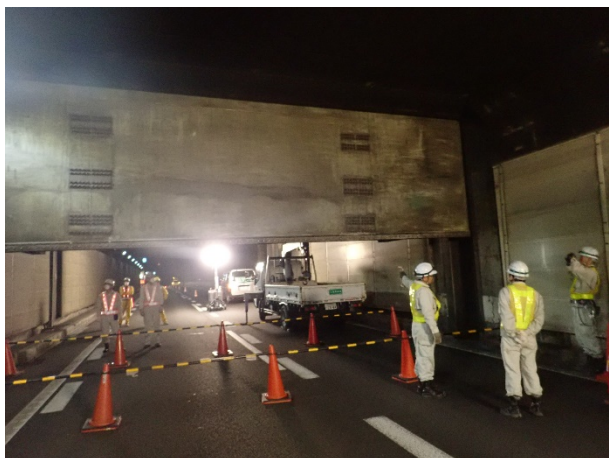
制水ゲートの点検
