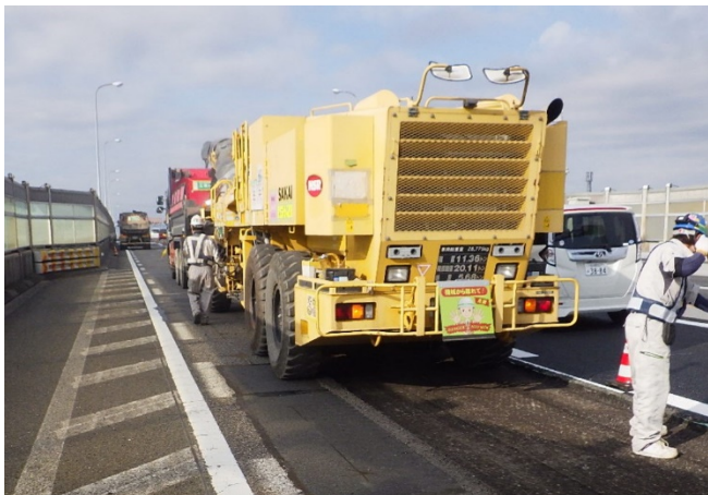
舗装補修工事
