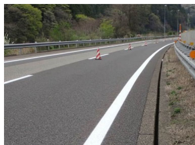
《路面標示の施工》
