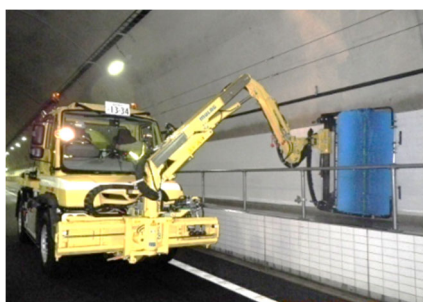
《トンネル側壁清掃》
