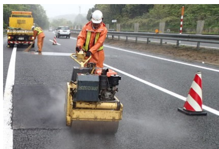
《路面損傷箇所の補修》
