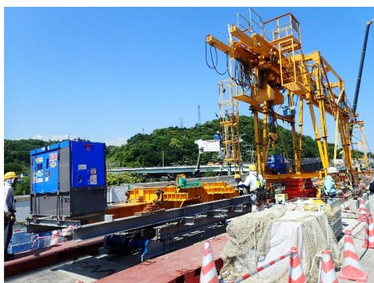
【床版取替機による床版設置状況】
