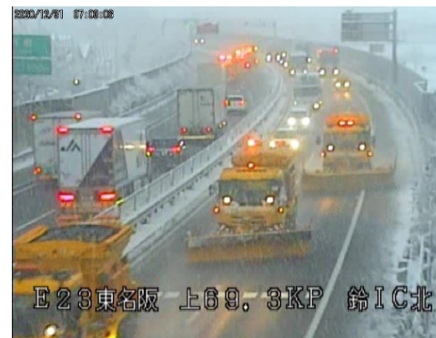
東名阪道 上69.3KP 付近除雪状況
