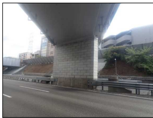
耐震補強後（他の工事の事例）
