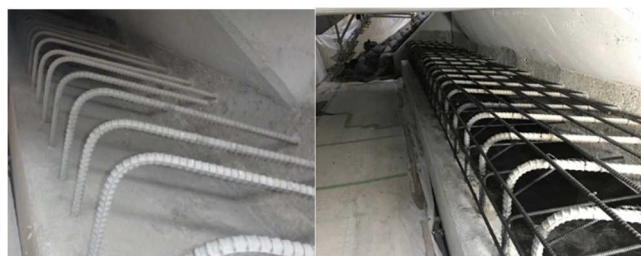
鉄筋の無い状態
