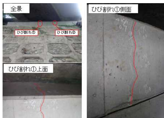
図 1 緑橋A1橋台にひび割れ
