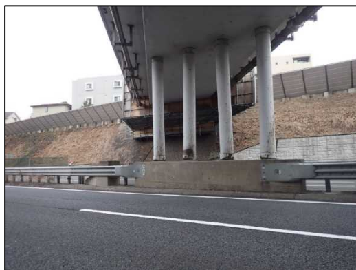
耐震補強前（他の工事の事例）
