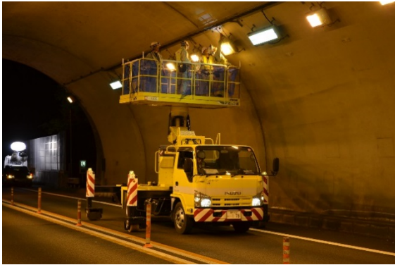
(トンネル照明設備点検)
