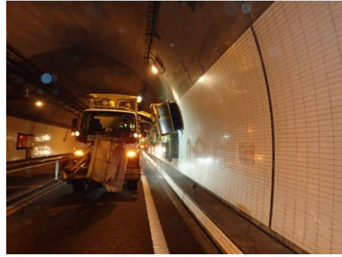
(トンネルの側壁清掃)
