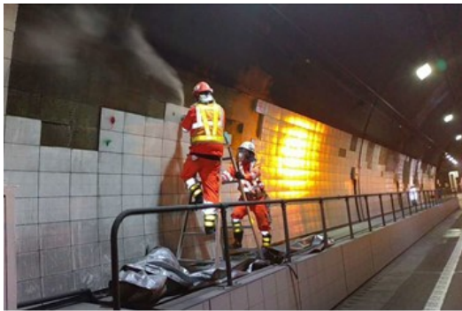
(トンネル内装タイルの撤去)
