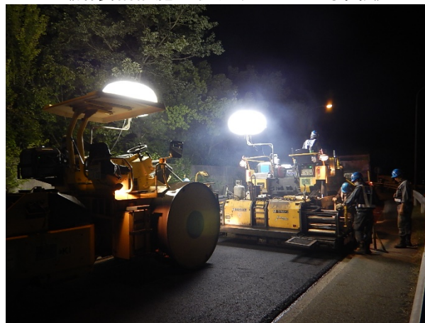
《舗装補修施工状況(イメージ写真)》
