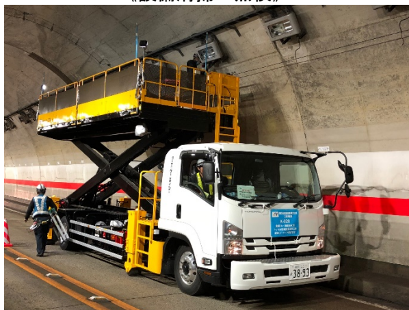
《設備清掃・点検》
