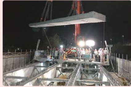
新しい床版の設置の様子
