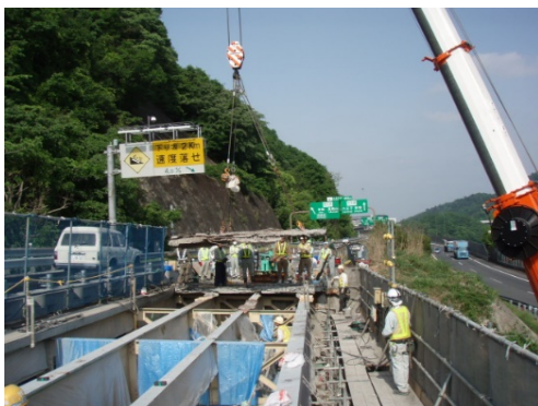
老朽化した床版の撤去
