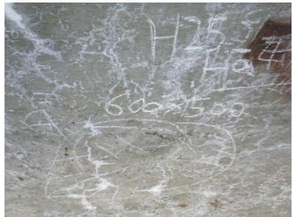
床版裏側の状況【拡大】
