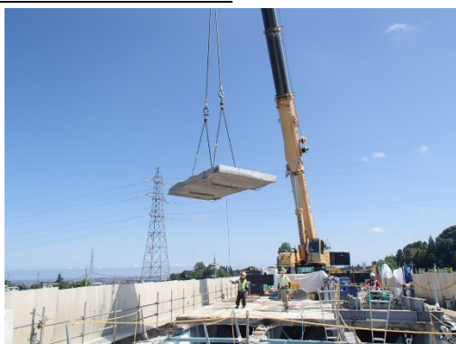
老朽化した床版の撤去
