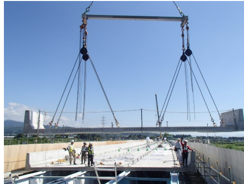
プレキャスト床版の施工状況
