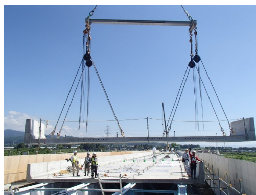
新しい床版の設置
