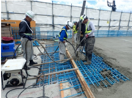
現場打ち床版の施工状況
