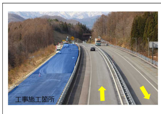
(施工例:切替前)
