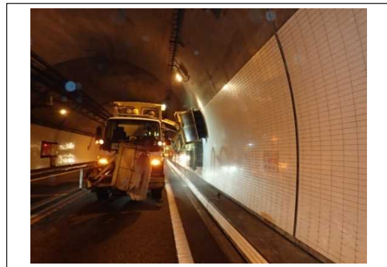
(トンネルの側壁清掃)
