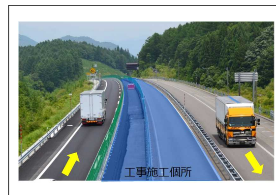
(施工例:切替後)
