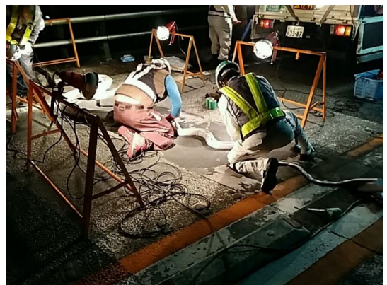
(伸縮装置補修)
