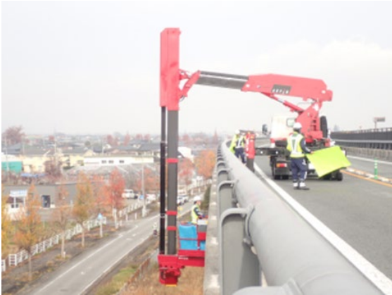
<橋梁点検状況>
