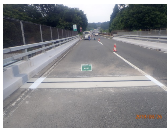
《伸縮装置取り替え後》
