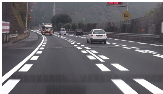
《路面標示の施工》
