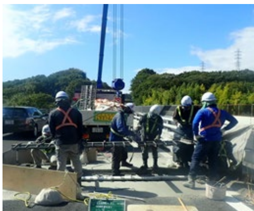
《伸縮装置の取り替え》
