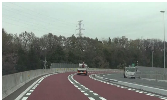
《カラー舗装の施工》
