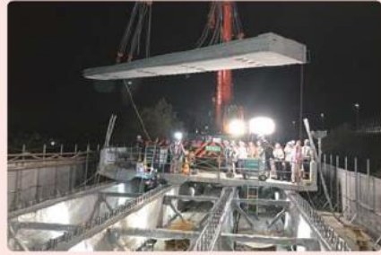
新しい床版の設置の様子
