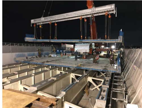
プレキャスト床版の施工状況
