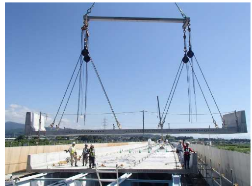
プレキャスト床版の施工状況
