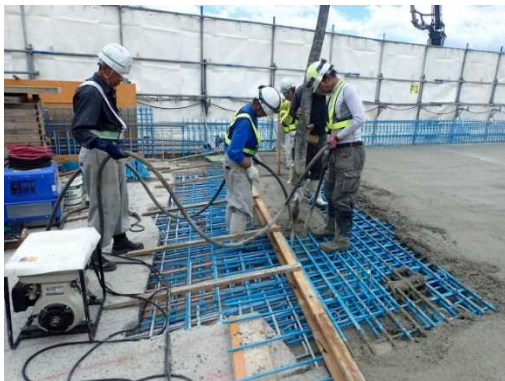
現場打ち床版の施工状況
