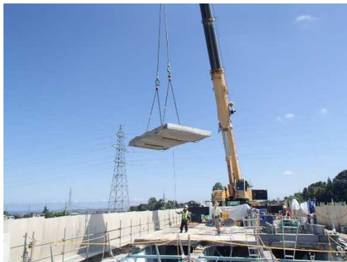
老朽化した床版の撤去
