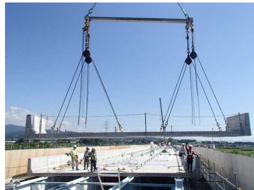
新しい床版の設置
