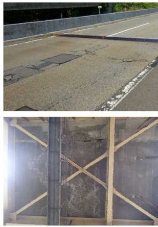
清水谷橋の損傷状況
