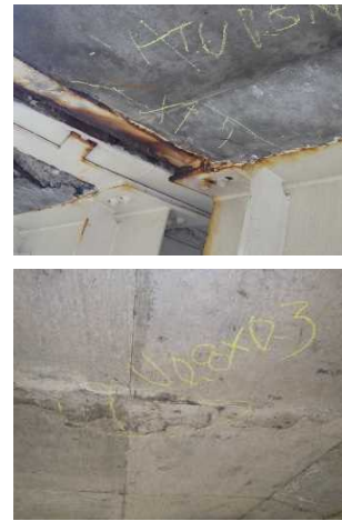
庄川橋の損傷状況
