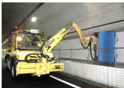
《 トンネル側壁清掃 》
