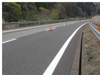
《 路面標示工の施工 》
