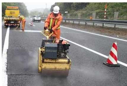
《 路面損傷箇所の補修 》
