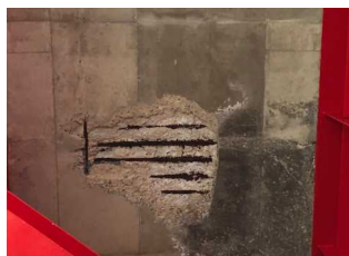
落合川橋の損傷状況 ※床版を下から撮影
