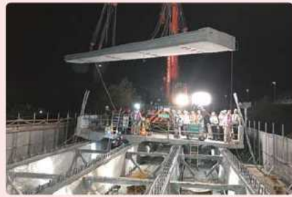
新しい床版の設置の様子
