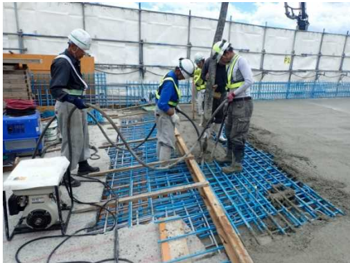
現場打ち床版の施工状況
