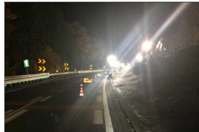
(テーパー部照明の設置例)
