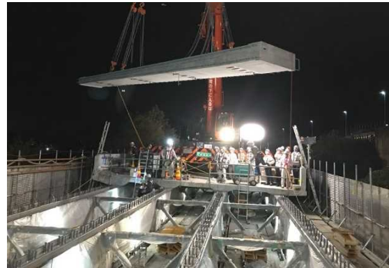
プレキャスト床版の施工状況
