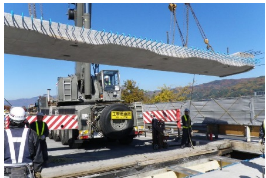
新しい床版の設置
