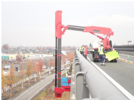
<橋梁点検状況>
