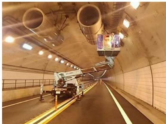
<トンネル設備点検状況>
