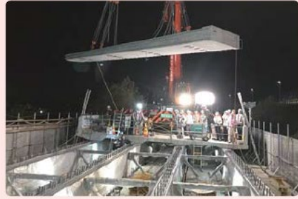
新しい床版の設置の様子
