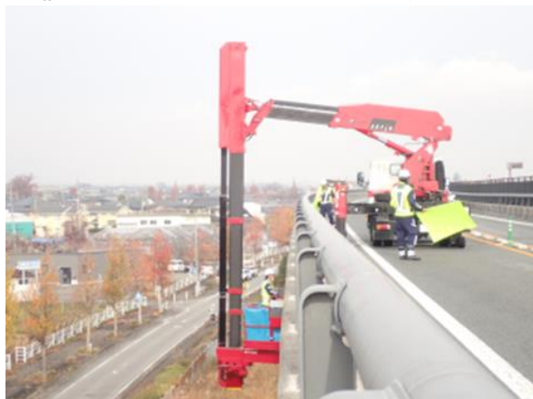
<橋梁点検状況>
