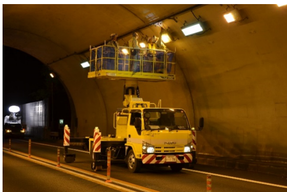
(トンネル照明設備点検)
