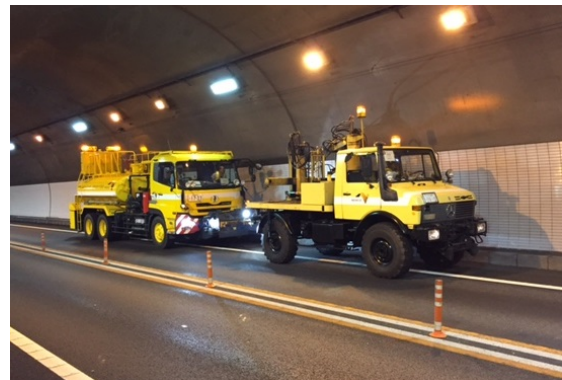
(トンネル側壁清掃)
