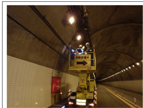
(トンネル照明設備点検)
